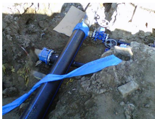
Imagem 3 – Ligações às condutas Existentes
