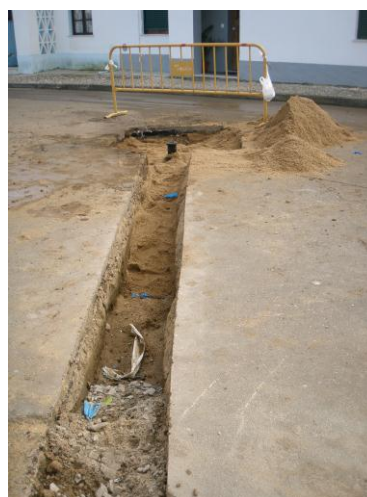
Imagem 5 – Ligações às condutas Existentes
