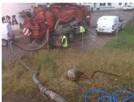
Imagem 7 – Camião de limpeza a retirar lamas
