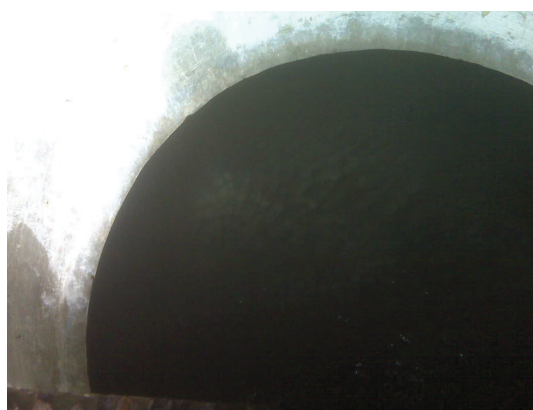
Imagem 8 – Enchimento após limpeza
