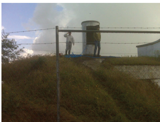
Imagem 5 – Entrada de um dos reservatórios
