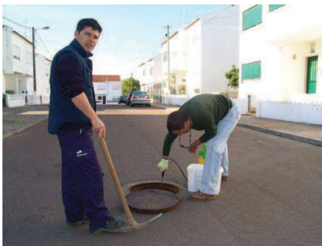
Imagem 9 – Desbaratização na rede de saneamento
