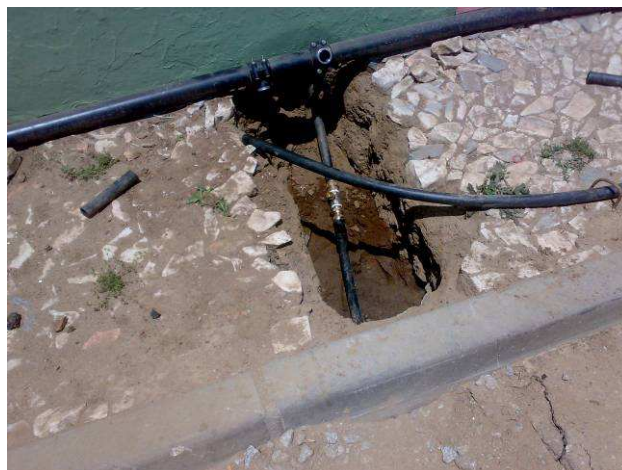
Imagem 12 – Ramal provisório e definitivo
