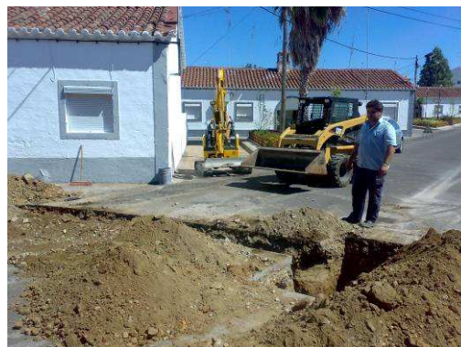
Imagem 14 – Picagem da conduta
