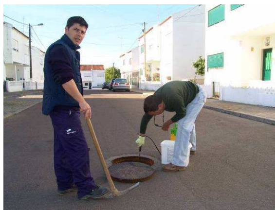
Imagem 20 – Desbaratização na rede de saneamento
