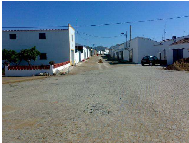
Imagem 9 – Obra de Degolados - Início
