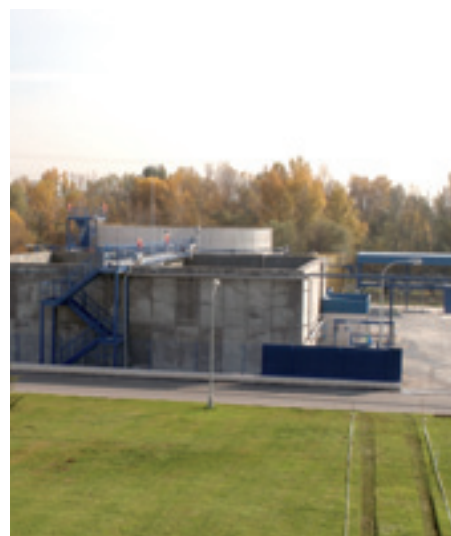
Estação de tratamento da Wyeth.
