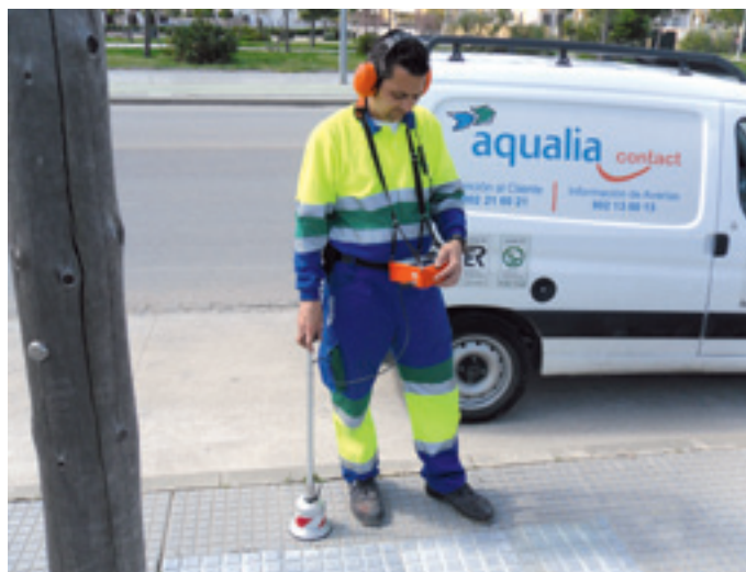
Pessoal da FCC Aqualia que executa tarefas de procura de fugas.
