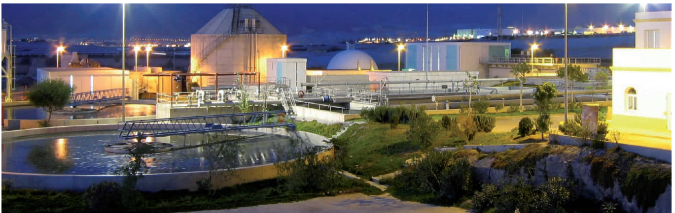
Night views of El Ejido's WWTP (Almería).
