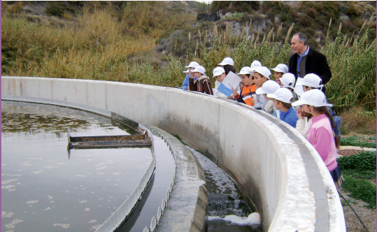
Open days at Berja's WWTP, Almería.
