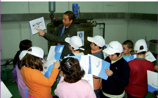
Open days at Berja's WWTP, Almería.
