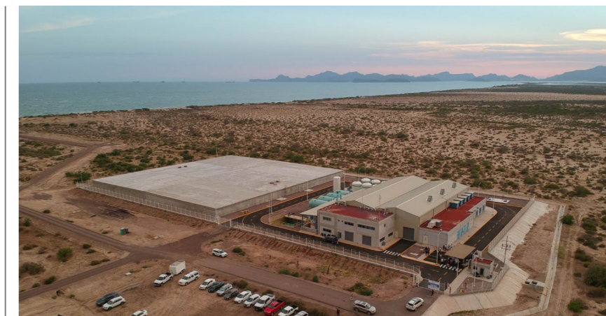
● Estação de dessalinização de água do mar em Guaymas, México.
